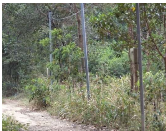
Padrões elétricos irregulares – sequência de padrões em um único terreno e padrão duplo num único lote.
